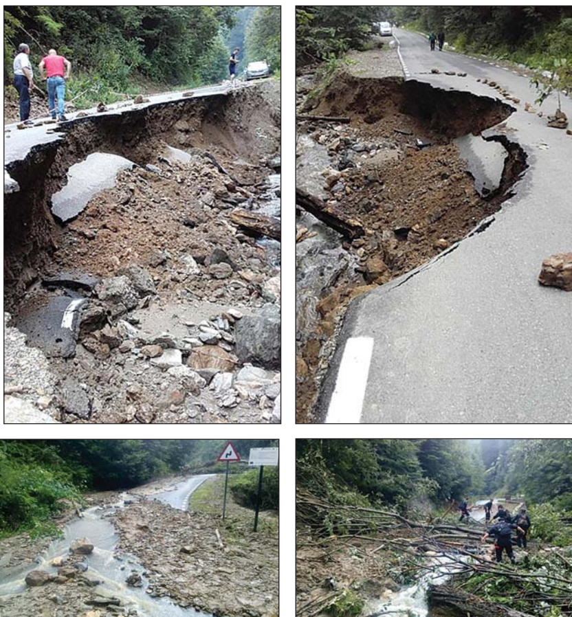
Foto 5-8. Drumul de acces către Sarmizegetusa Regia după calamitățile din vara anului 2018 (sursa: https://www.mediafax.ro/social/drumul-spre-sarmizegetusa-regia-distruș-de-ape-trebuie-reparat-in-5-zile-de-firma-care-l-intretine-galerie-foto-15554437/gallery-15554649/8 )
